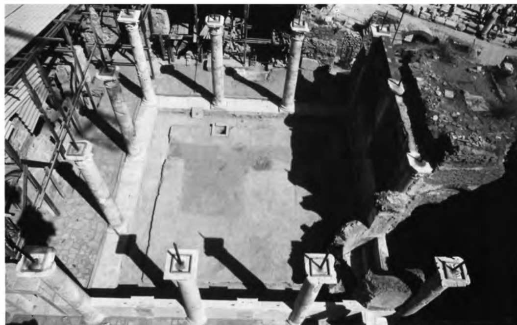
Abb. 9: Peristylhof 31a nach Fundamentierungsarbeiten
