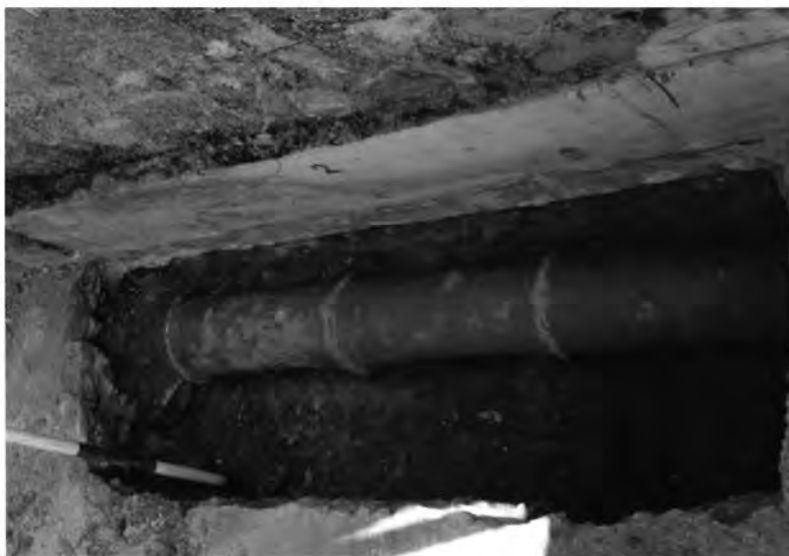
Abb. 29: Peristylhof 31a, Tonrohrleitung in Fundamentgrabung F4/6
